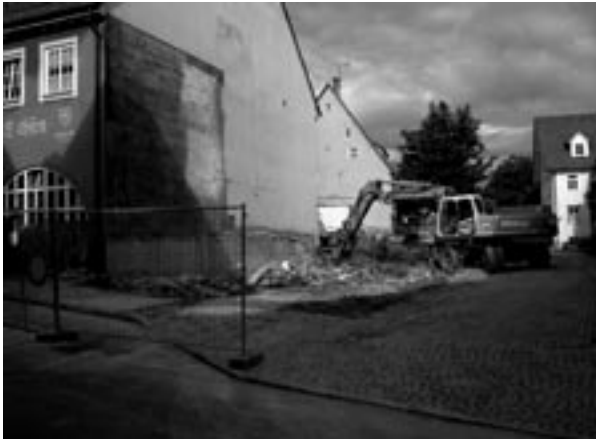
Platz für den Neubau der Bücherei: Der Abriss des Gebäudes Marktstraße 23 ist innerhalb weniger Tage bewerkstelligt
