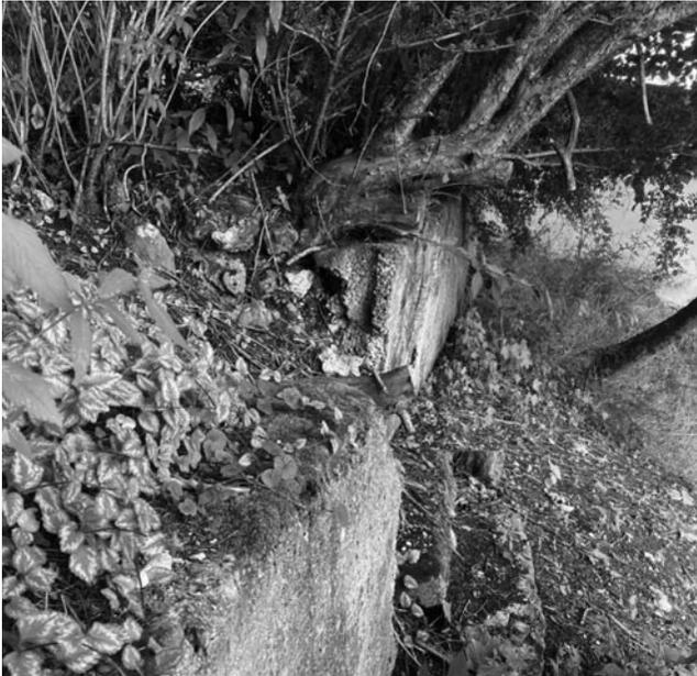
Die Mauer oberhalb vom ehemaligen Rössle-Standort in Mägerkingen befindet sich im fortgeschrittenen Verfall. Um die beträchtlichen Investitionen des heutigen Besitzers Lorch zu stützen, plant die Stadt eine Instandsetzung der Mauer, auch um dadurch die Voraussetzungen für den Bau eines neuen Fusswegs zu schaffen
